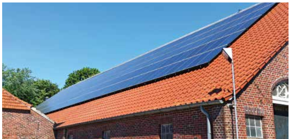
Photovoltaikanlage auf dem Stallgebäude
