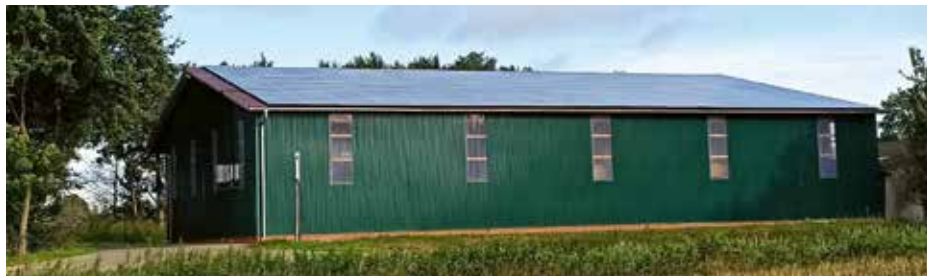
Photovoltaikanlage auf einer Maschinenhalle
